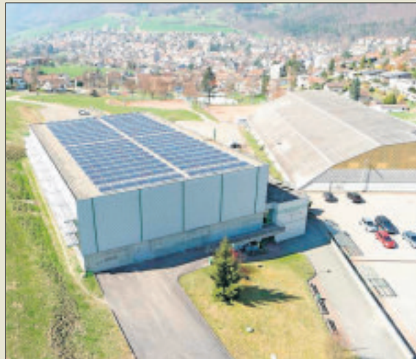
La centrale photovoltaïque de la halle polysport vue d'un drone.
